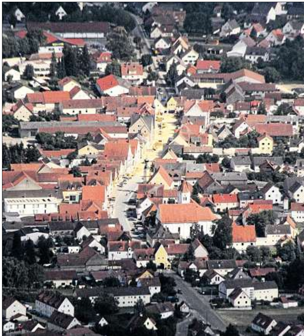
Nach der Kanalsanierung kommt der Straßenbau: Der Rennertshofener Gemeinderat hat den Auftrag für Gehwege, Parkplätze und Fahrbahn an der Marktstraße für rund 1,53 Millionen Euro vergeben. Foto: Schanz
